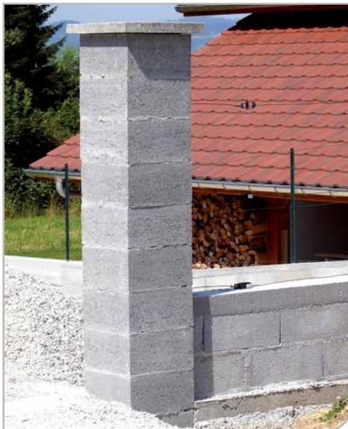
**Nota :** le béton de remplissage doit avoir une composition proportionnelle à celle-ci : 30 litres de graviers, 15 litres de sable, 7 kg de ciment, 4 litres d'eau pour le pilier à crépir. Pour le pilier à finition moulé : 1 seau de ciment (CEM1-CPA42,5), 2 seaux de sable 0/2 ou 0/4, 2 seaux de graviers (4/8 à 4/25) et ½ seau d'eau.
